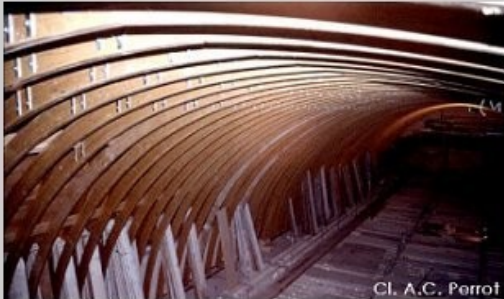
Ossature du couvrement de la Salle des Pas Perdus
