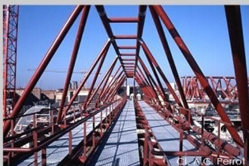
Charpente métallique de l'aile Sud
