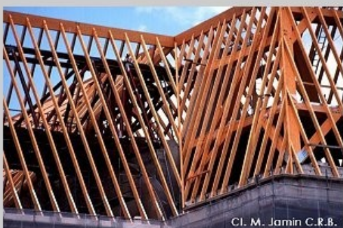
Réalisation de la charpente en bois
