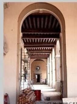
Restauration des galeries
