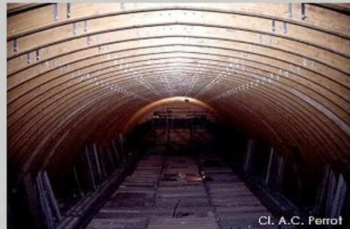
Ossature du couvrement de la Salle des Pas Perdus
