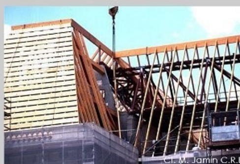
Réalisation de la charpente en bois
