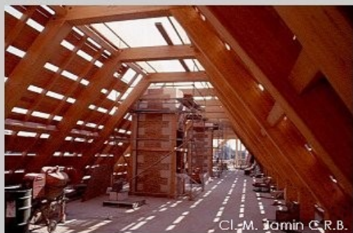
Reconstruction des cheminées
