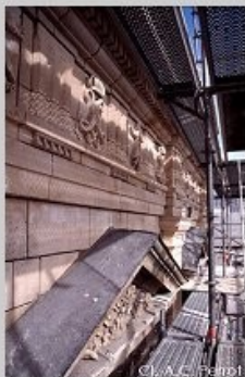
Restauration des frises taillées dans le tuffeau
