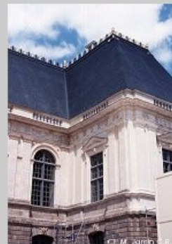
Restauration et nettoyage des façades
