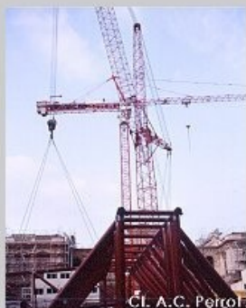
Grue de 1000 tonnes pour la pose de la charpente
