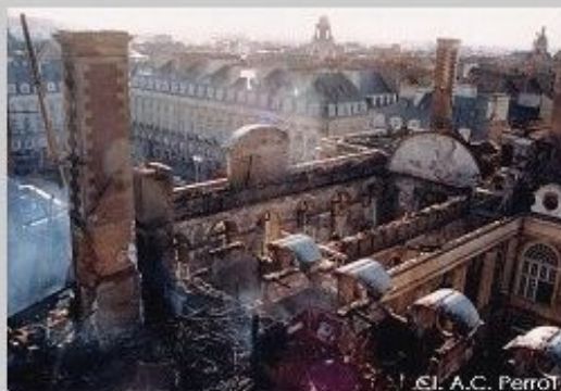
Vue générale sur l'aile sud
