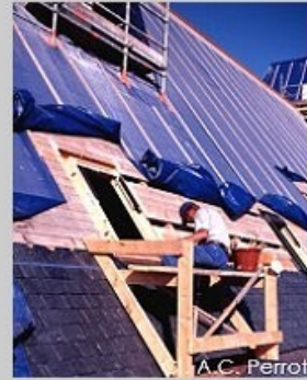
Réalisation de la couverture
