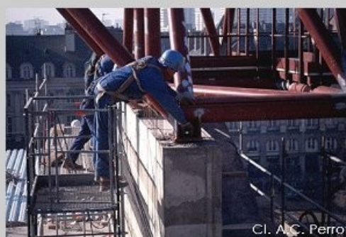
Ancrage de la charpente métallique
