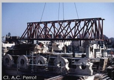
Pose de la charpente métallique
